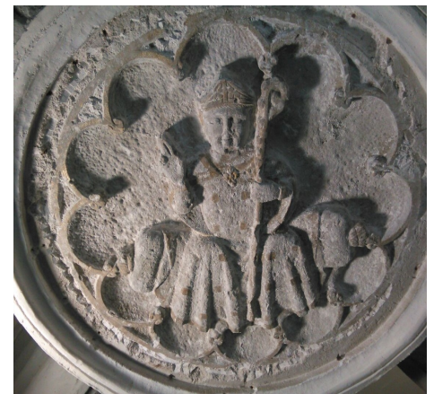
Imagen de la clave medieval durante el proceso de eliminación del yeso que la ocultaba
