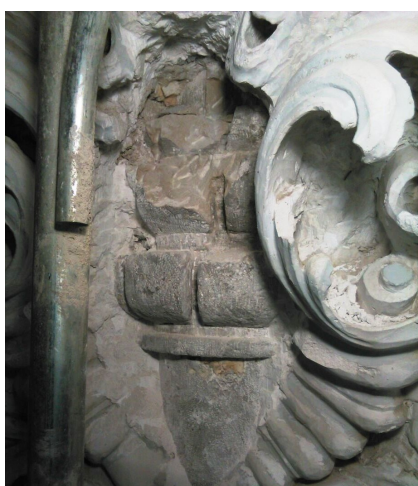
Decoración barroca sobre la ménsula original. Planta baja
